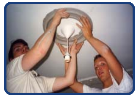
Beim Anbringen einer Stuckrosette
