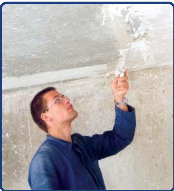
Es kann gestrichen werden - die Vorarbeiten sind abgeschlossen
