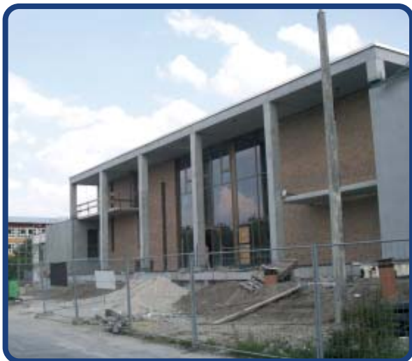
Hier noch als Baustelle - aber mittlerweile ist die Schwimmhalle fertig
